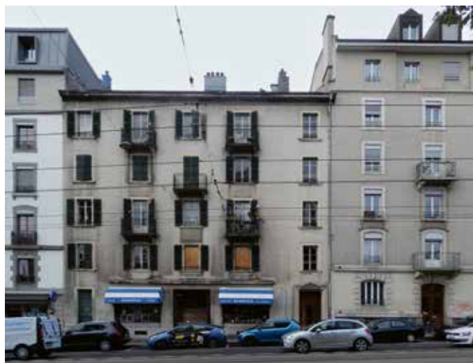
Vue du bâtiment existant avant travaux (CALANCHINI GREUB ARCHITECTES)
